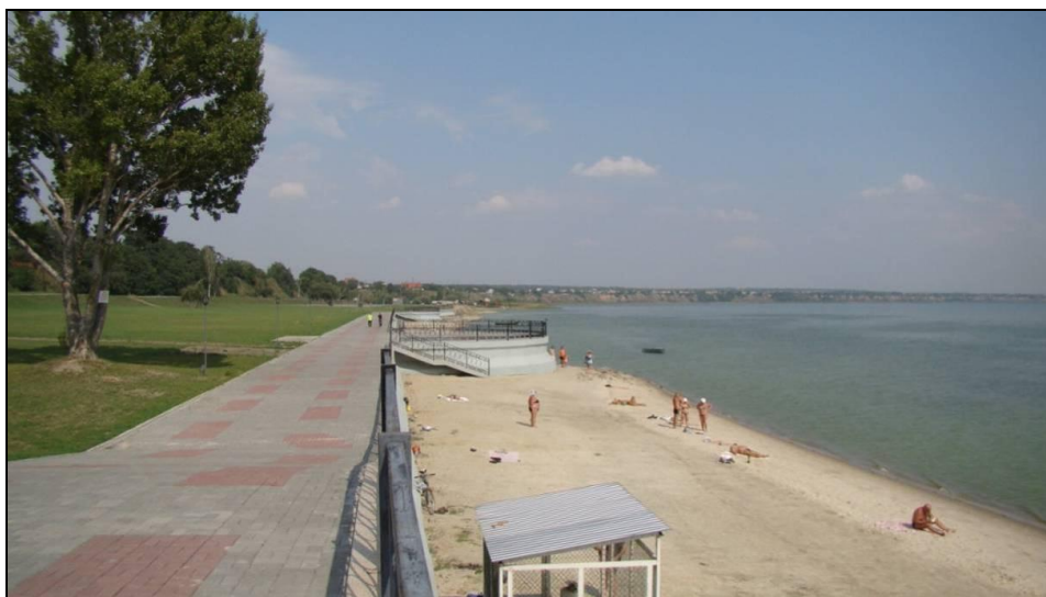
Рис.12 . Берегоукрепительное сооружение в районе ООО «Приазовье».
