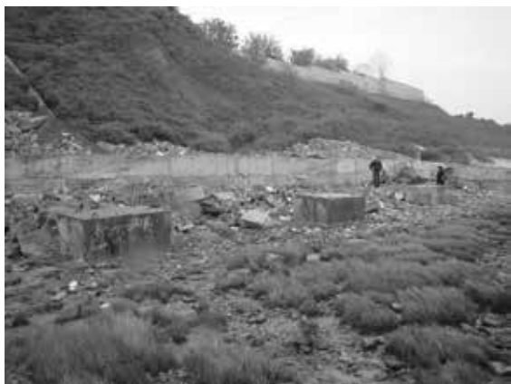
Рис. 8. Участок побережья от Приморского пляжа до Центрального пляжа – строительство берегоукрепления.
