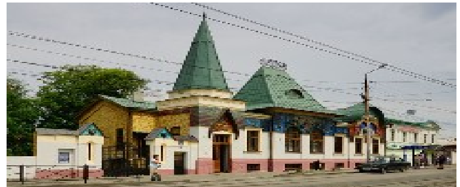
Музей «Градостроительство и быт г. Таганрога»
