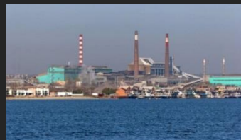
АО «ТАГАНРОГСКИЙ МЕТАЛЛУРГИЧЕСКИЙ ЗАВОД»
