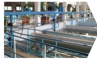
МУП «УПРАВЛЕНИЕ «ВОДОКАНАЛ»
