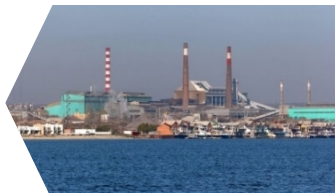
АО «ТАГАНРОГСКИЙ МЕТАЛЛУРГИЧЕСКИЙ ЗАВОД»
