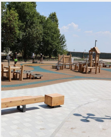
Реконструкция Пушкинской набережной
